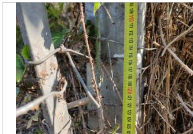
Trace sur le montant
