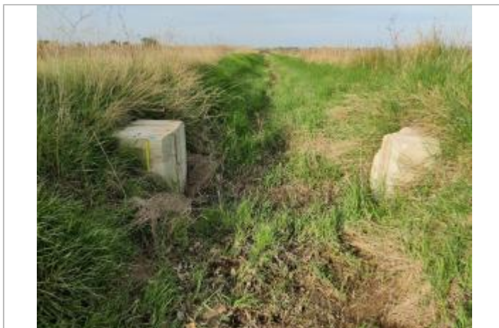
Batardeau de fossée
