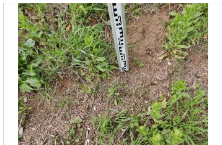
Dépôt contre la digue
