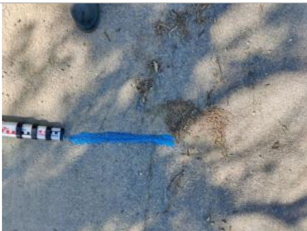
Dépôt sur le chemin
