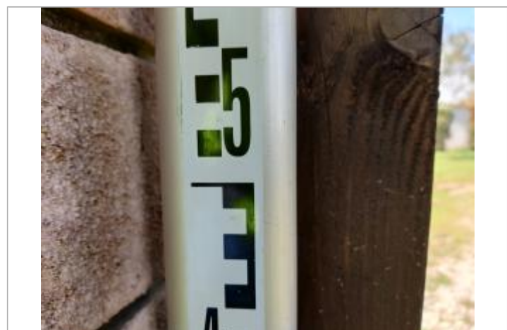
Trace sur le montant
