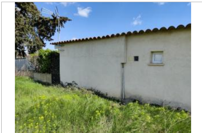
Mur de la maison
