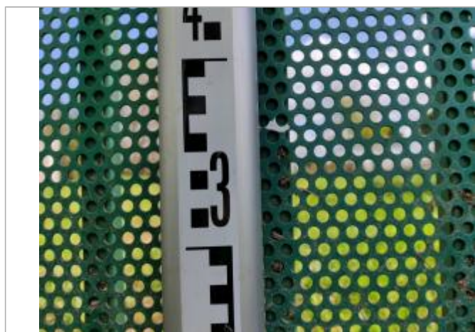
Trace sur le portail, 54cm sous le repère de crue de 1953
