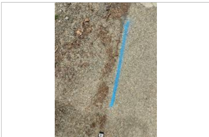
Dépôt sur la chaussée
