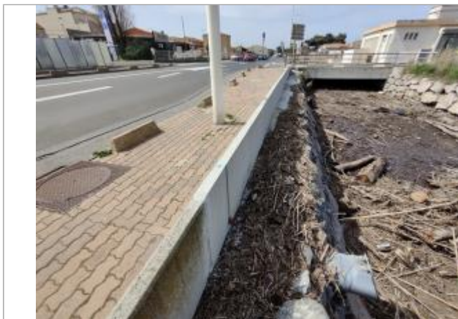
Mur digue du canal
