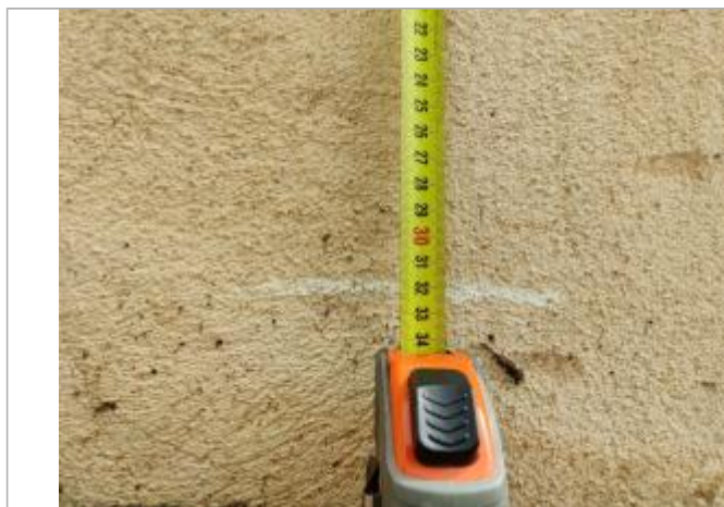
Trace sur le massif Béton
