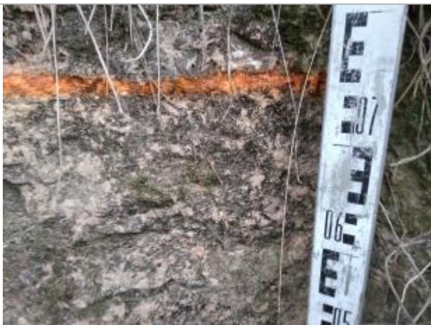
Trace sur le culée du pont
