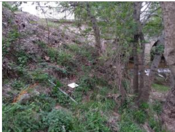
Berge à l'aval du pont
