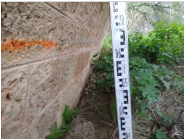
Trace sous l'arche de pont
