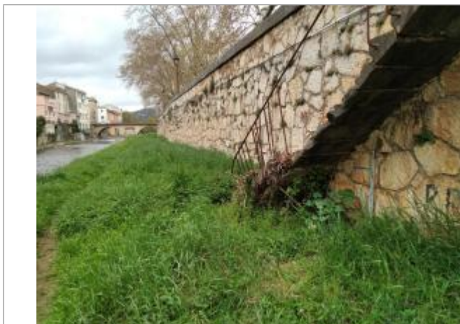
Mur de soutènement
