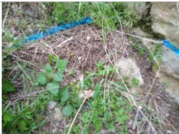
Dépôt contre la culée
