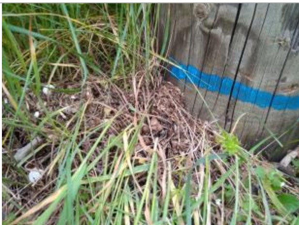
Dépôt contre le pylône
