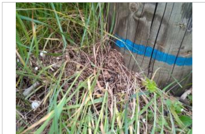
Dépôt contre le pylône
