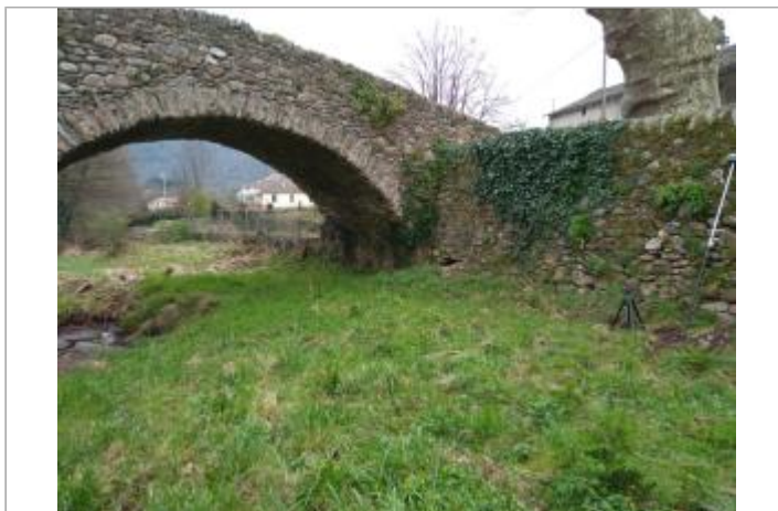
Mur de soutènement
