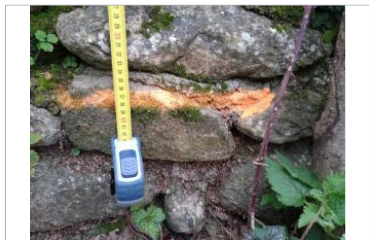
Trace sur le muret
