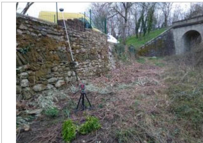
Mur de soutènement
