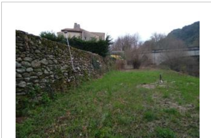
Mur de soutènement
