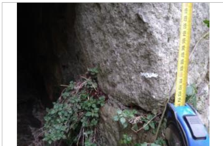
Trace dans le cadre pluvial
