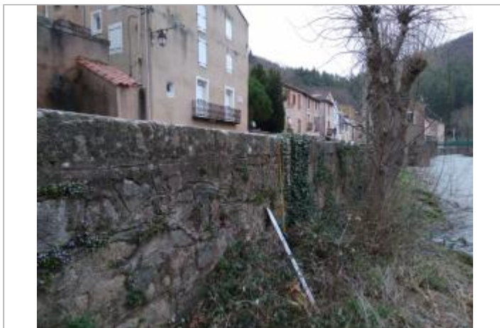
Mur de soutènement du quai des Tanneries
