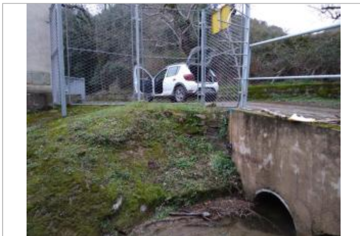
Ponceau du Coural
