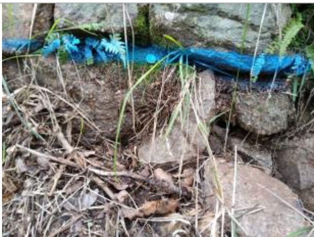
Trace sur le mur
