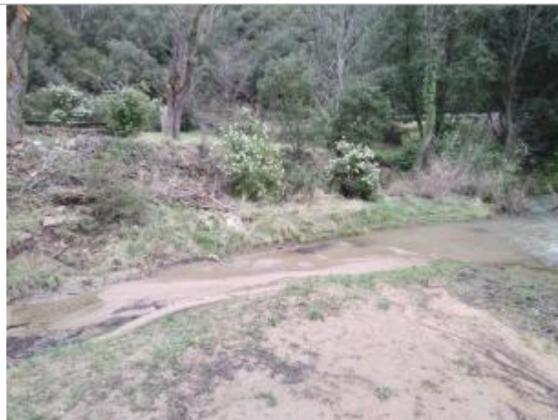
Mur de soutènement
