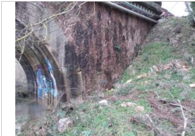
Culée du pont
