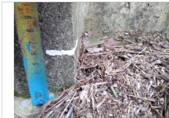
Trace sur le pylône
