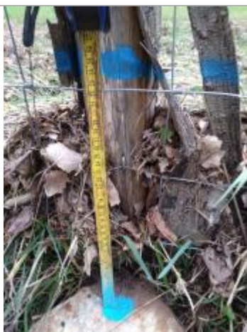
Débris végétaux dans le grillage
