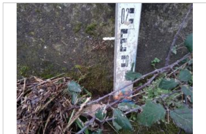
Trace sur le mur
