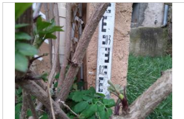
Trace sur le muret
