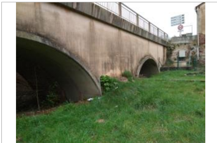
Deuxième arche du pont
