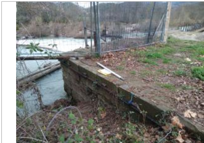
Ouvrage de prise d'eau
