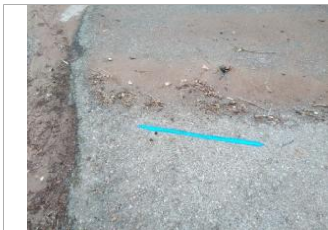
Dépôt sur la chaussée
