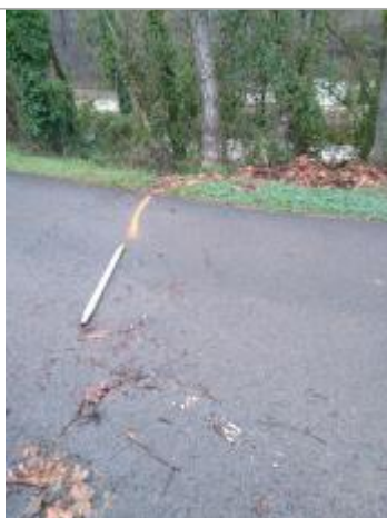
Dépôt sur la chaussée
