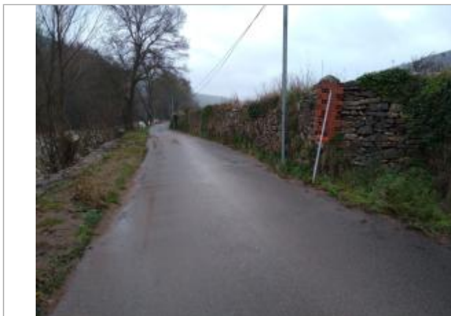
Mur de soutènement
