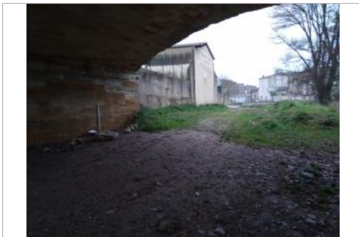
Culée de pont
