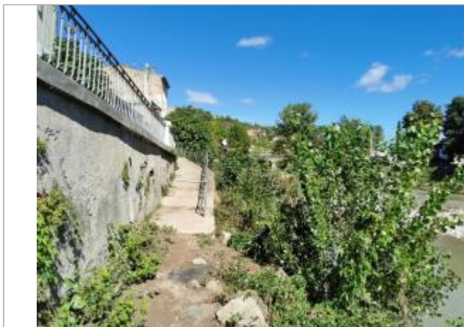
rampe d'accès au cours d'eau
