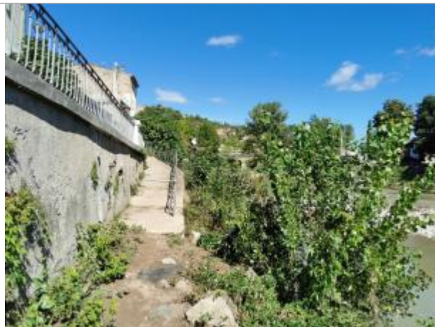
rampe d'accès au cours d'eau
