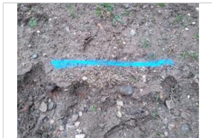
Dépôt sur le talus et ligne d'érosion
