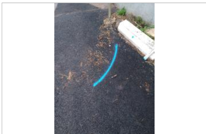
Dépôt sur la chaussée
