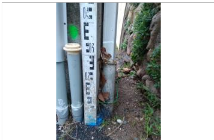
Débris végétaux accrochés au pylône
