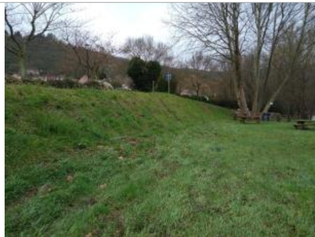
Talus de route
