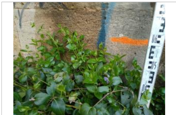
Trace sous l'arche
