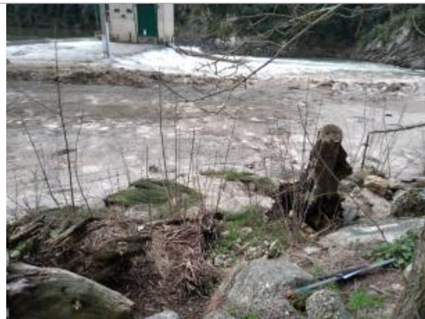
Enrochement du seuil
