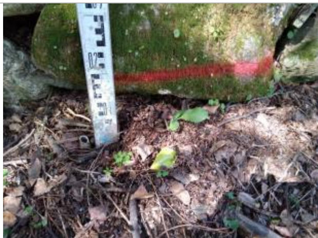
Dépôt contre le mur
