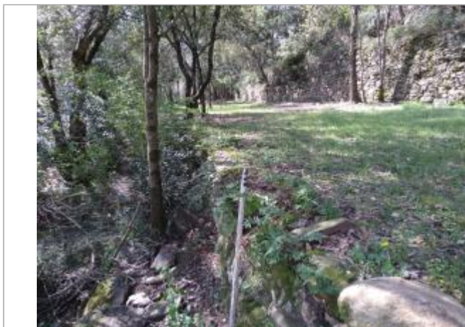
Mur en pierre
