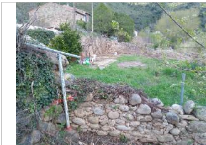
Angle de mur entre les deux potagers
