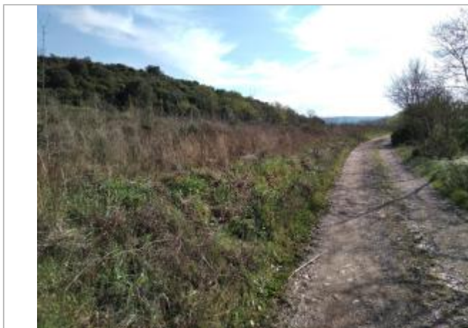
Talus de bord de chemin
