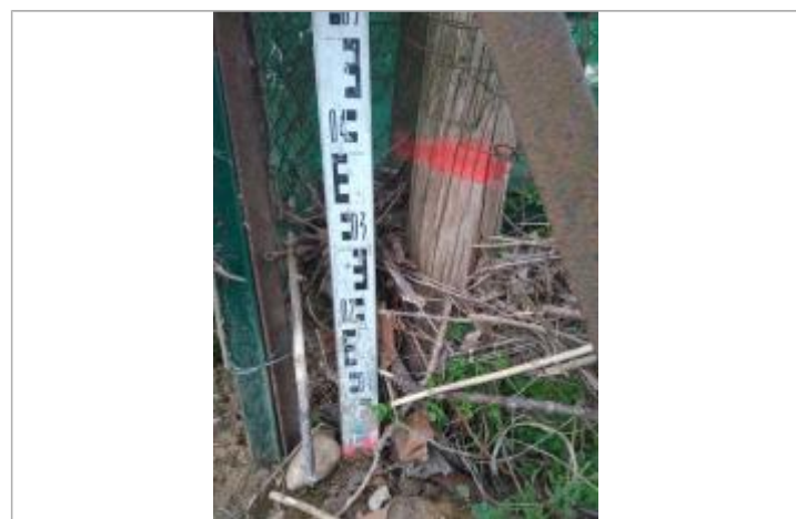
Débris végétaux accrochés au grillage
