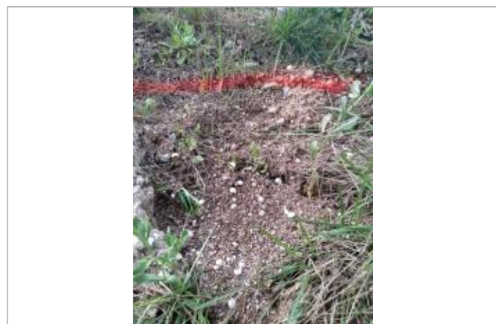
Dépôt dans le fossé
