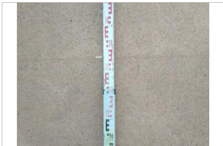
Trace sur le mur
