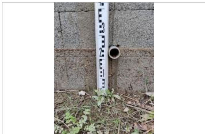
Trace sur le mur
