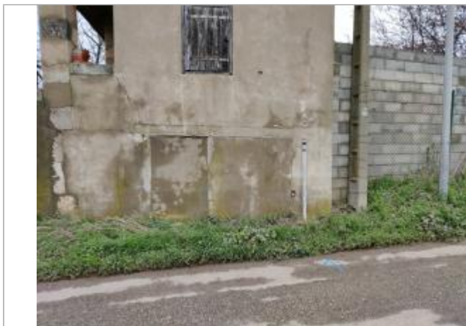
Mur de bâtiment
